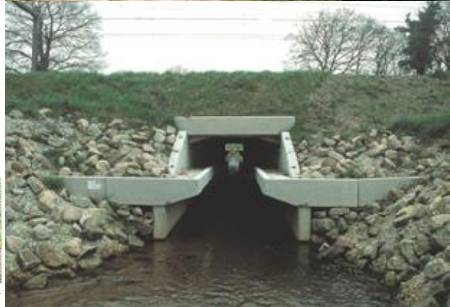
Dassentunnel met goede aansluiting op raster
