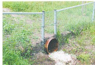
Dassentunnel met goede aansluiting op raster
