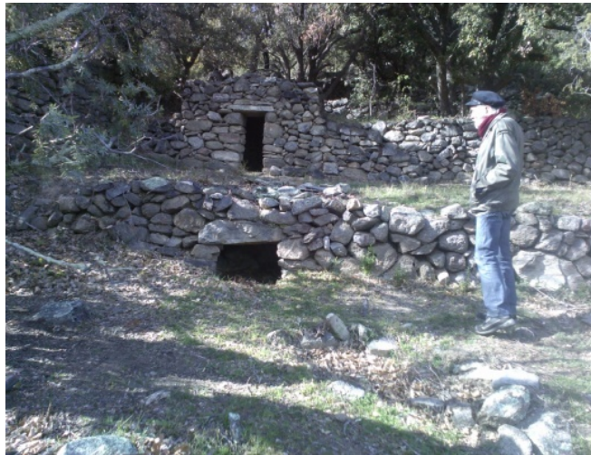
Protection d'une source
