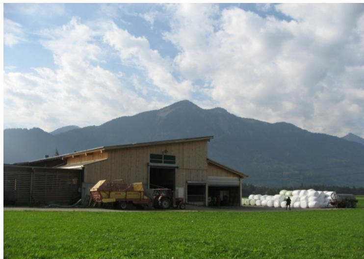
Nouveau bâtiment d'élevage en Autriche
