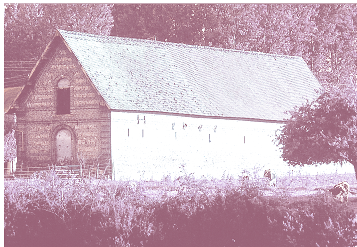
Grange en pierres et briques en Normandie, France
