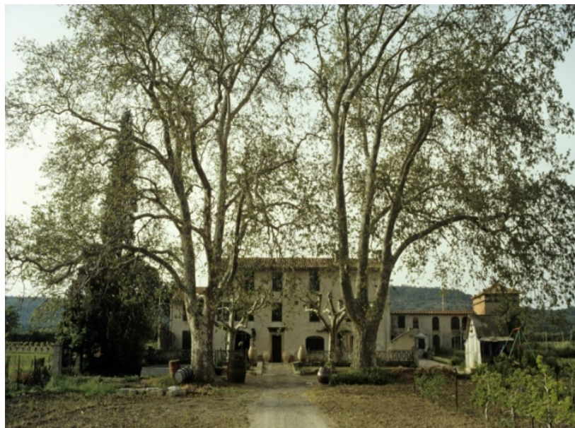
Deux fois deux platanes encadrant le bâtiment agricole traditionnel transformé en maison d'habitation
