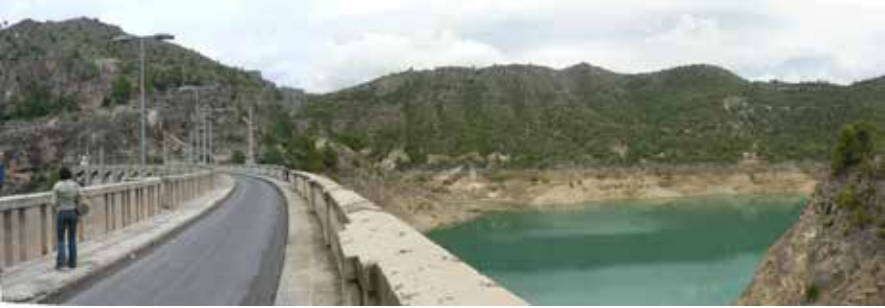
Fuensanta dam (Albacete, Spain)
