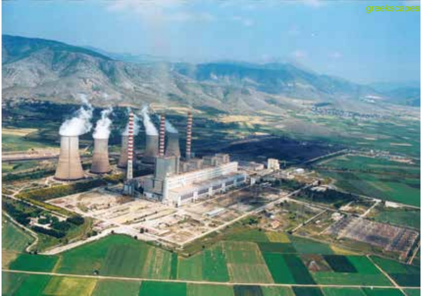
Α.Η.Σ. Αγ. Δημητρίου, Πτολεμαΐδα • Lignite power station, Ptolemais, Kozani
